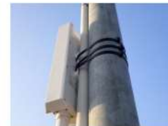
支柱への設置
